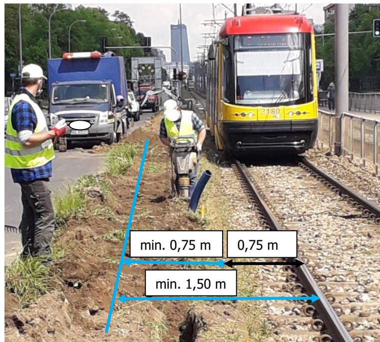
Zdj. 1. Prace budowlane wykonywane przy czynnym ruchu tramwajowym z naruszeniem zewnętrznych pasów bezpieczeństwa.
